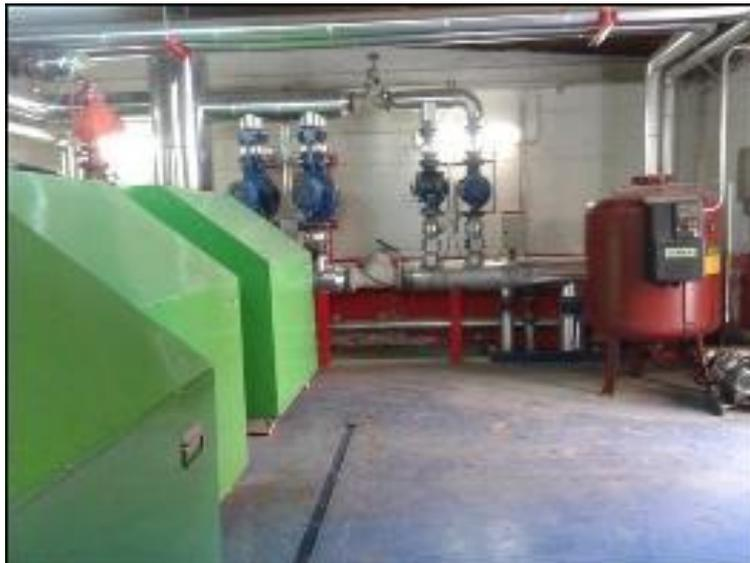
Figura 5. Sala de calderas existente de gas natural (Fase 2)
